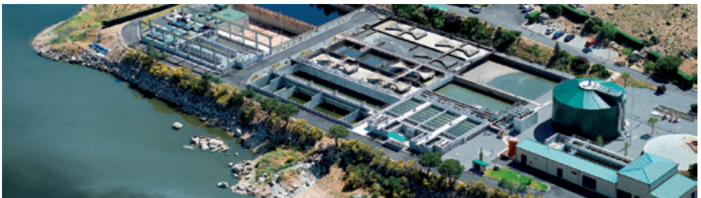
Vista aérea de la EDAR de Ávila.
