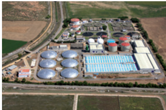
Vista aérea de la EDAR La Ranilla.
