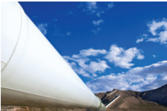
Acueducto Realito, México.
