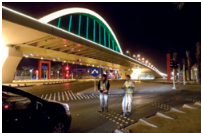
Sectorización y control de fugas en Riad, Arabia Saudí.
