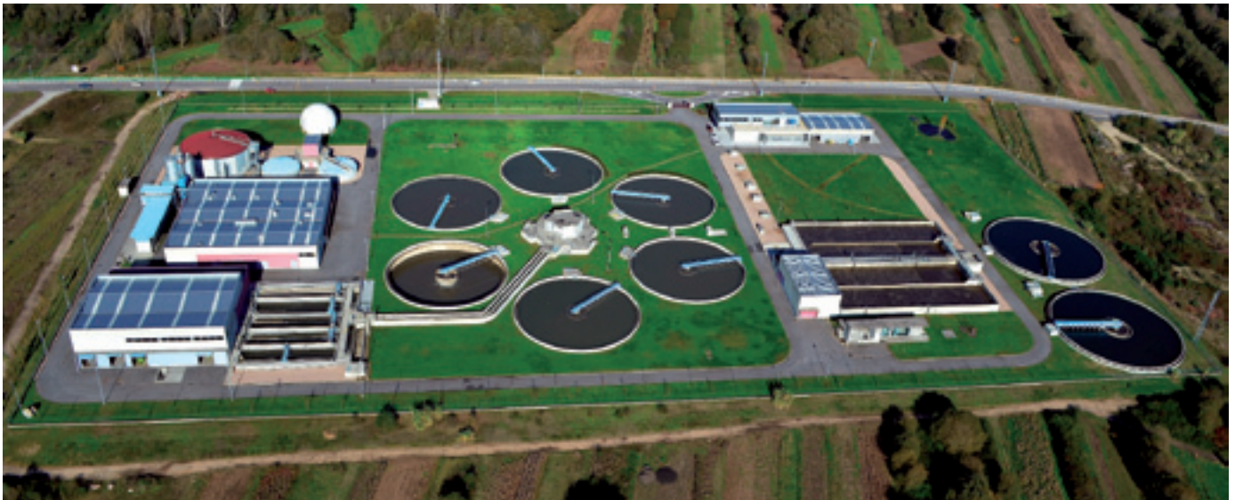
Vista aérea de la EDAR de Guillarei donde se desarrolla el proceso ELAN® que reduce el gasto energético de la depuración.
