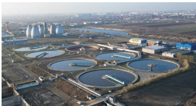
Vue aérienne de l'usine de Glina, la station d'épuration la plus importante de Roumanie.
