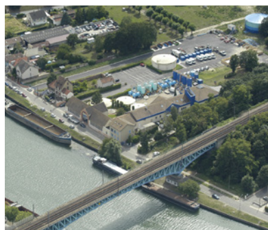
● Instalaciones SEFO en Andresy, Francia.
