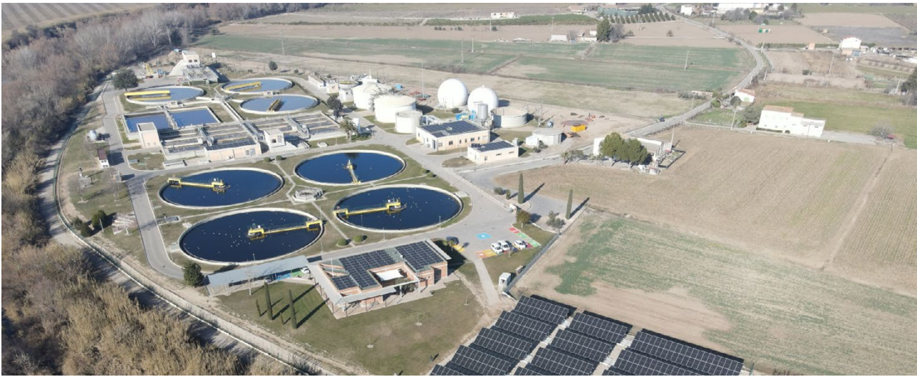
Station d'épuration des eaux usées (SEEU) de Lleida, Catalogne, Espagne.
