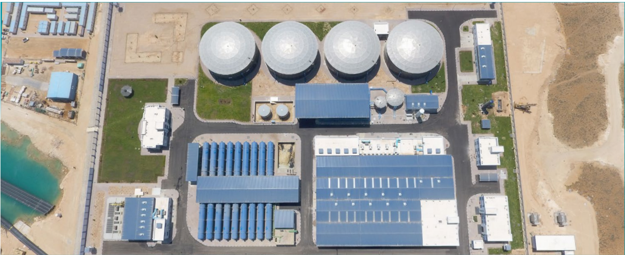
Installation de dessalement d'eau de mer (IDEM) El Alamein, Égypte.
