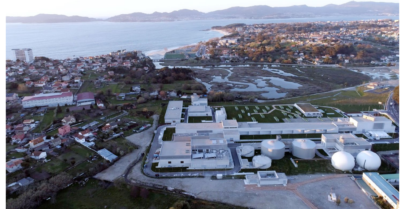
Station d'épuration des eaux usées (SEEU) Lagares, Vigo, Pontevedra, Espagne.
