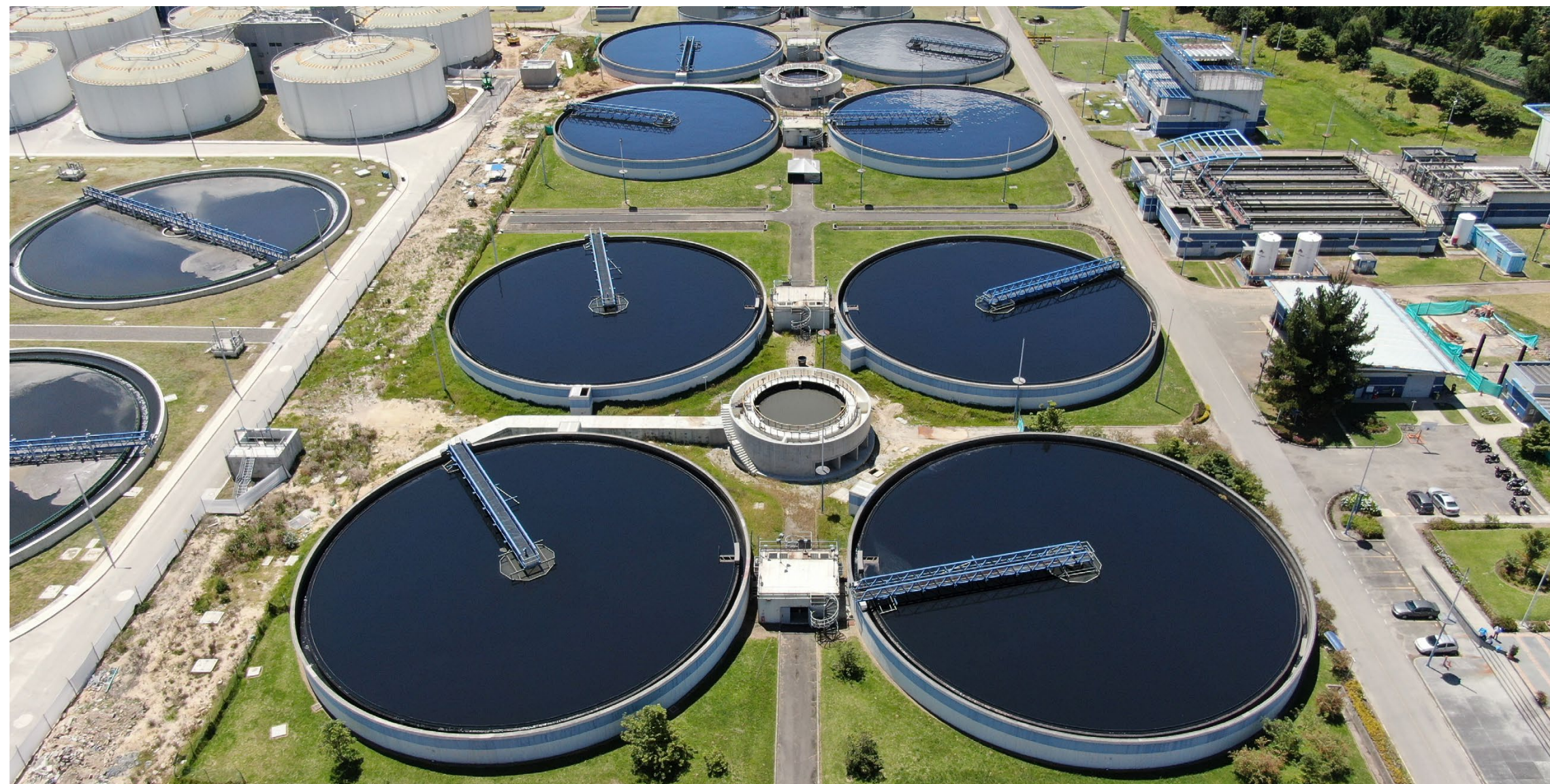
Station d'épuration des eaux usées (SEEU) El Salitre, Bogotá, Colombie.
